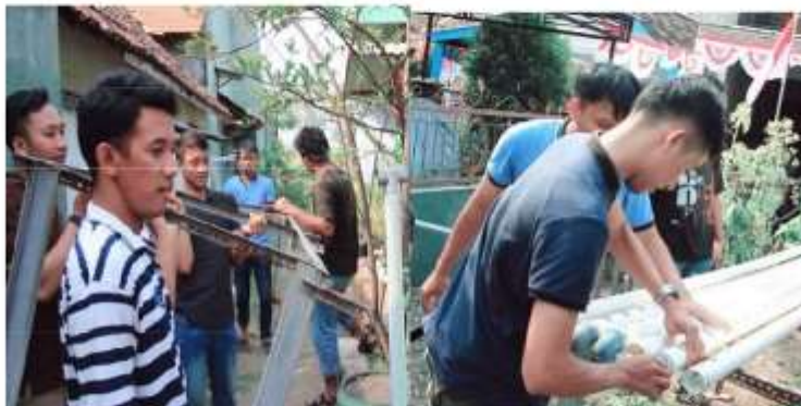
Gambar 3: Memasang Pipa
