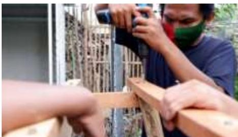
**Gambar 2.12 Pembuatan Tumpuan Filter Air**
