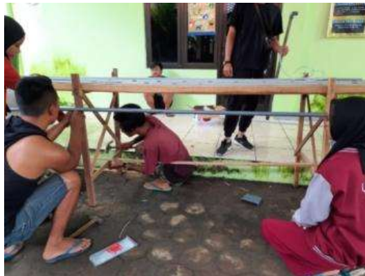
Gambar 2.4 pemasangan instalasi Hidroponik
