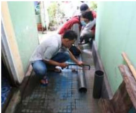
Gambar 2.9 Proses pemotongan pipa paralon
